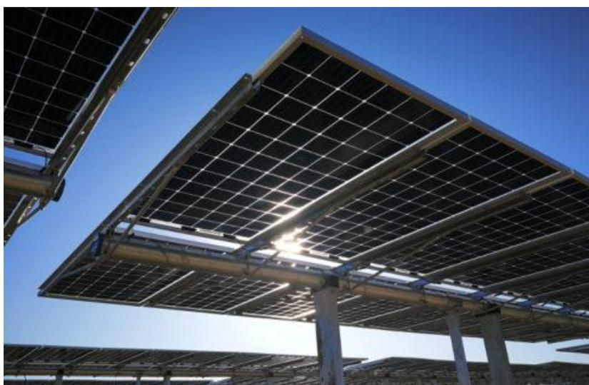
Figura 3.2: Esempio di struttura a tracker monoassiale
