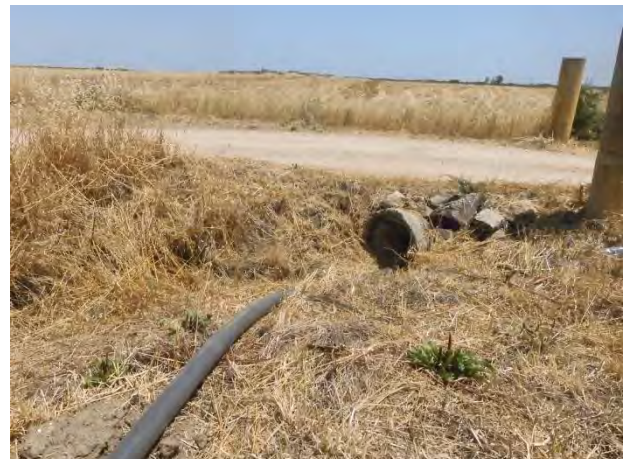
Figura 50 Part.IIa cat. 183. Angolo NE. Vista da W. Canale moderno
