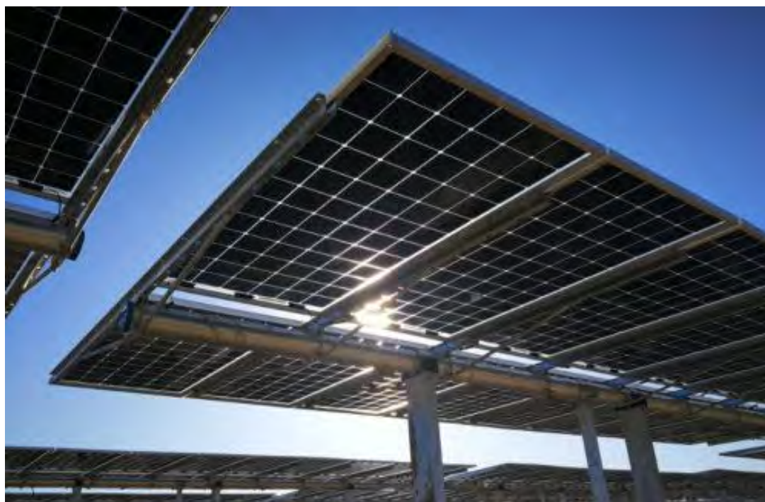
Figura 4.6: Esempio di struttura a tracker monoassiale
