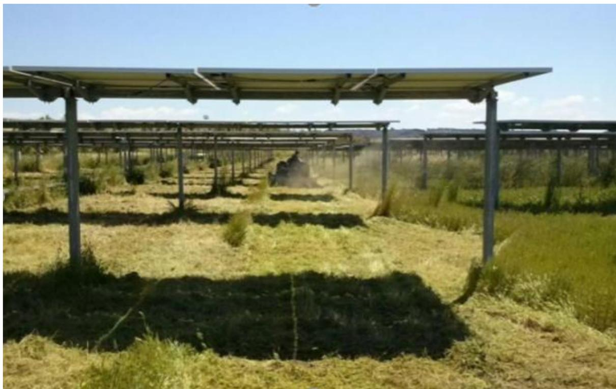
Entrando nel merito, per le lavorazioni meccaniche si utilizzerà un trattore piattaforma di tipo “frutteto”, di potenza CV 120, adeguato a svolgere agevolmente le diverse operazioni colturali.
