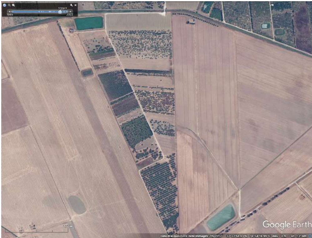
Area dell'Impianto FV. Acquisizione Google Earth Pro Luglio 2017
