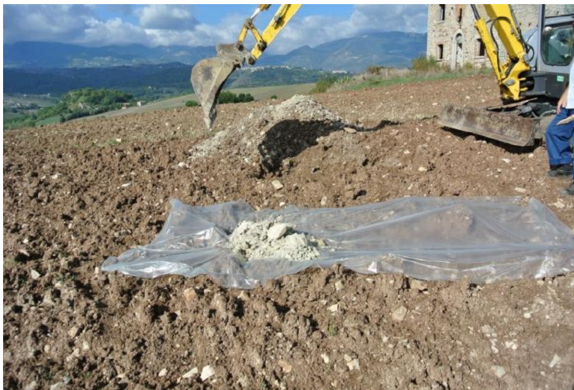
Figura 4 – Esempio campionamento terre: scavo trincee.
