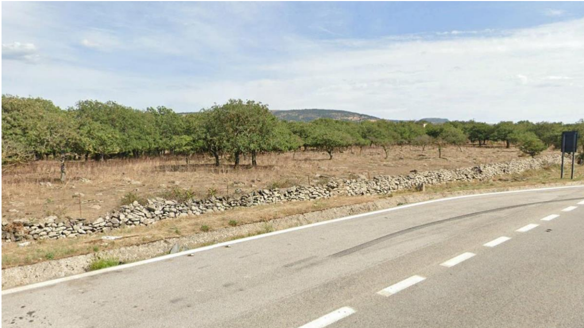
Figura 31: vista su area futura complanare nord
