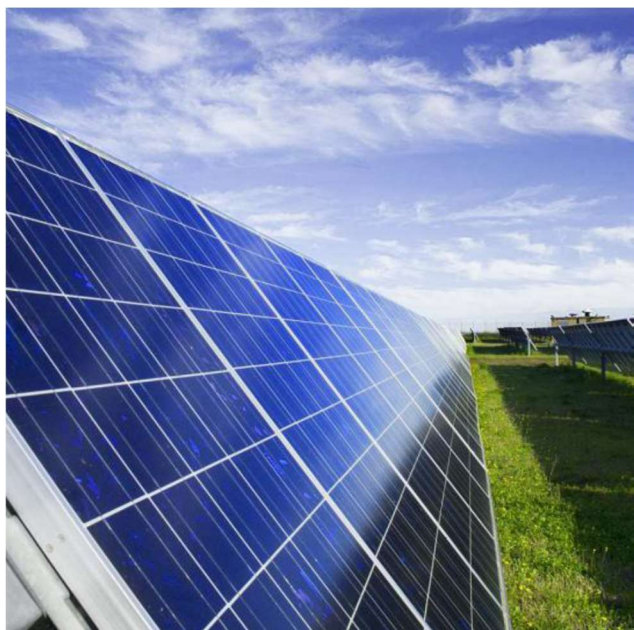
Figura 6.1 Esempio di installazione tracker
