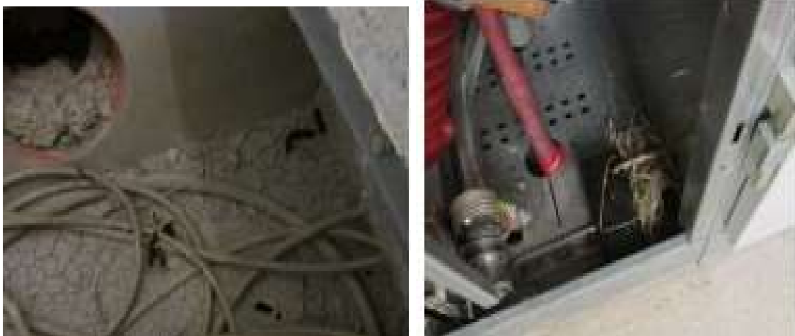
Figura 8.6 Presenza di escrementi di roditore
