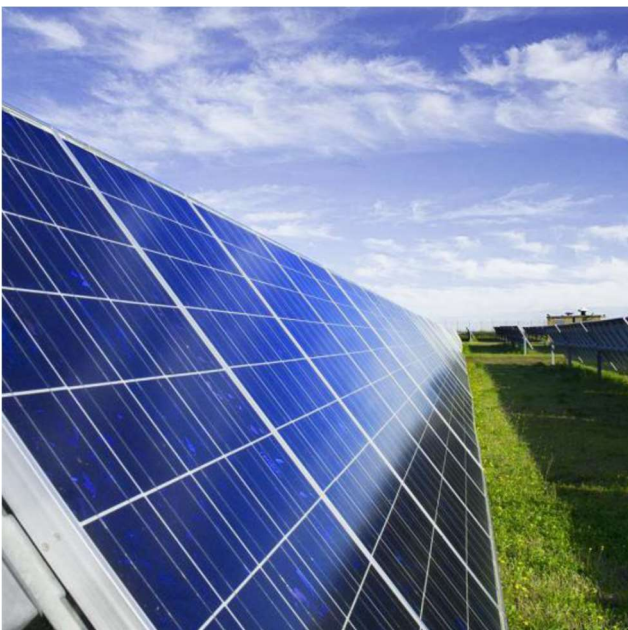
Figura 3.1 Esempio di installazione tracker
