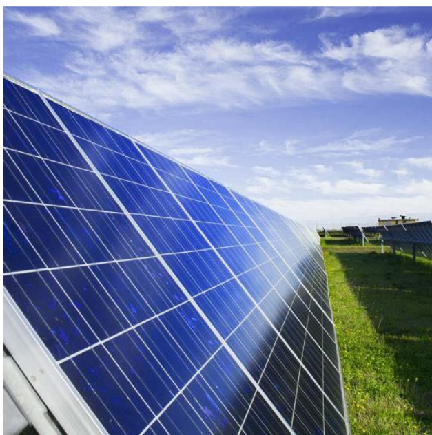
Figura 2.3 Esempio di installazione tracker
