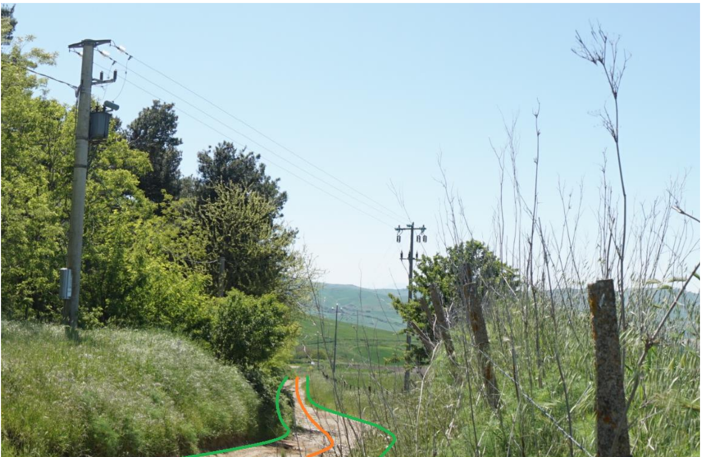
Figura 23 ripresa fotografica dell'area definita boschiva con indicazione tracciato cavidotto interrato (in arancione) e viabilità da adeguare (in verde).
