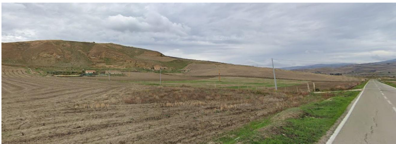
Figura 6 ripresa fotografica dell'area impianti per la connessione alla RTN.
