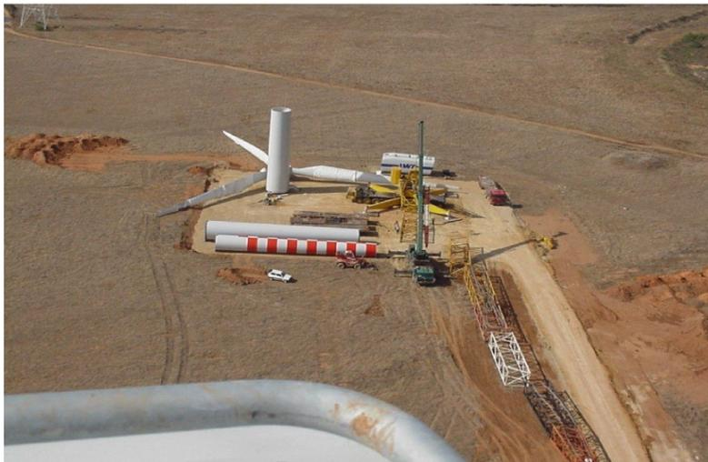
Figura 9 –Piazzola per il montaggio dell'aerogeneratore
