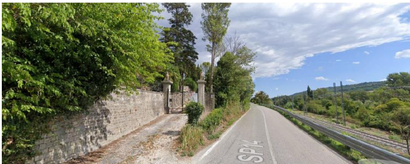
Figura 4 Foto del muro di recinzione della Villa Perugini da Via Clemantina
