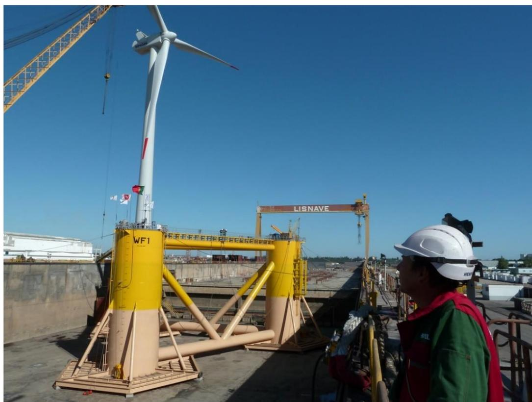
Figura 6-4 – Fasi di assemblaggio della piattaforma galleggiante (Fonte Windfloat Atlantic Project)
