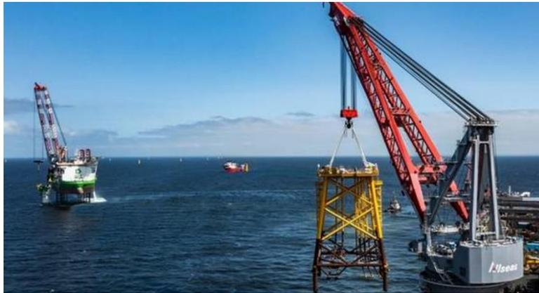
Figura 6-9 Installazione: Jacket lifting and lowering
