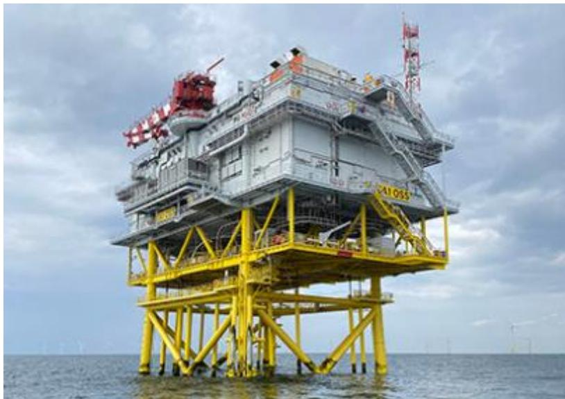
Figura 5-2 – Ipotesi di stazione di trasformazione off-shore a fondazione fissa
