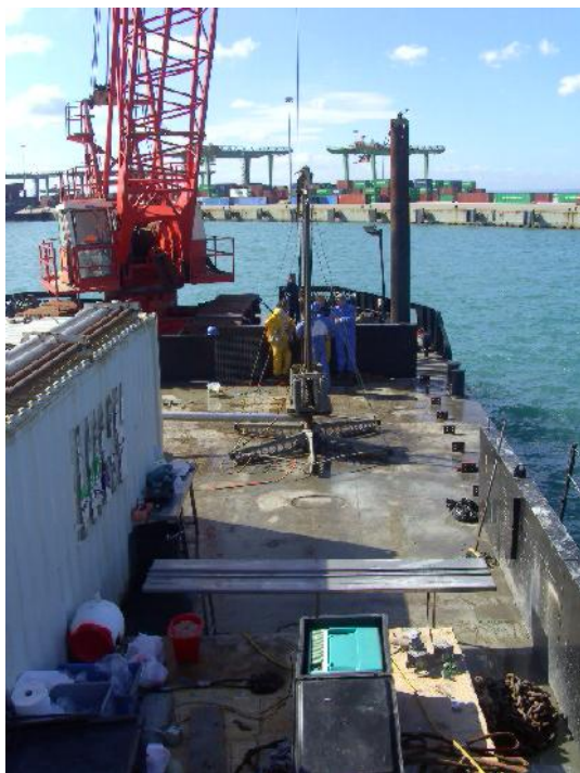
Foto 3 – Allestimento cantiere di bordo
