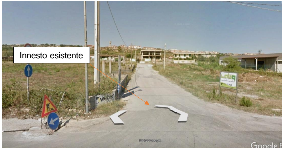
Figura 3.1.2 Innesto della strada di accesso sulla SP1
