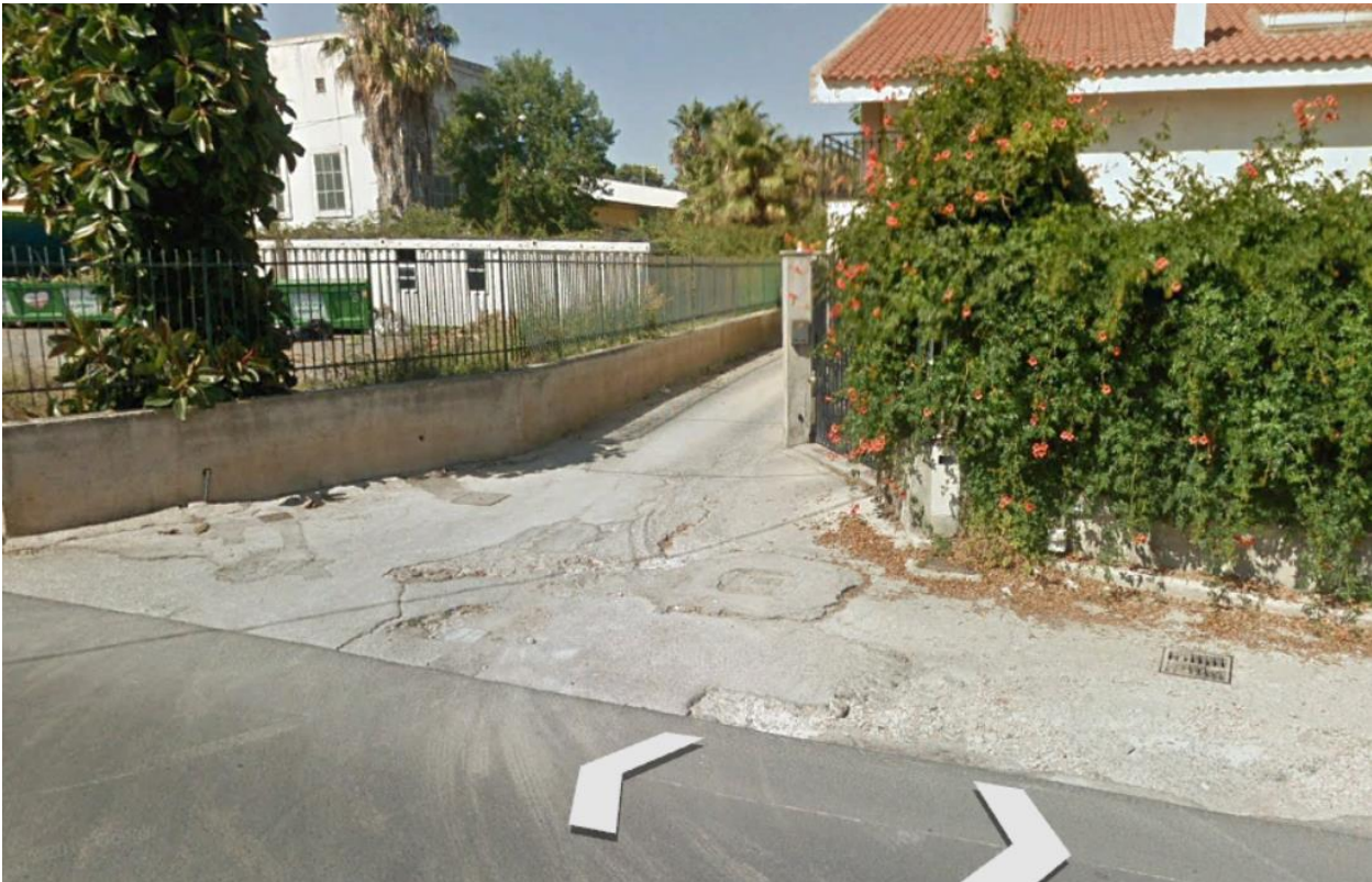
Figura 3.1.1 Innesto della strada di accesso sulla SP1
