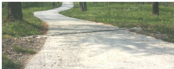
Pavimentazione drenante realizzata con stabilizzanti naturali terreno
