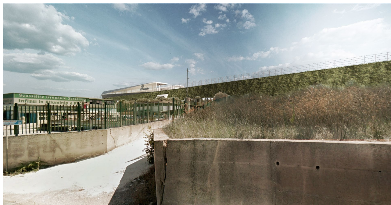
Fig. 2 e 3 – La stazione vista dalla Strada Provinciale 1. Ante e post operam.
