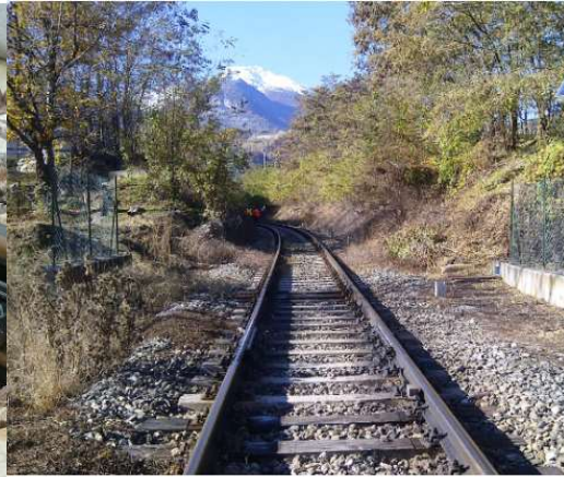
Impianto lubrificazione P.A.L. Italia (Foto: P.A.L. Italia; 2012)
