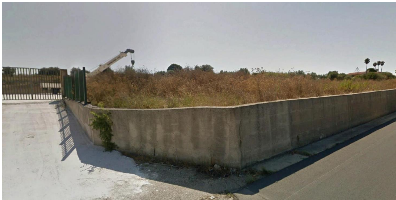
Figura 7-21 Aree di Cantiere Fisso AT.01 Ambito Piana Costiera
