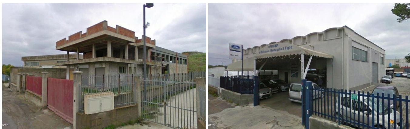
Figura 7-10 Manufatti ad uso produttivo, artigianale e commerciale oggetto di demolizione
