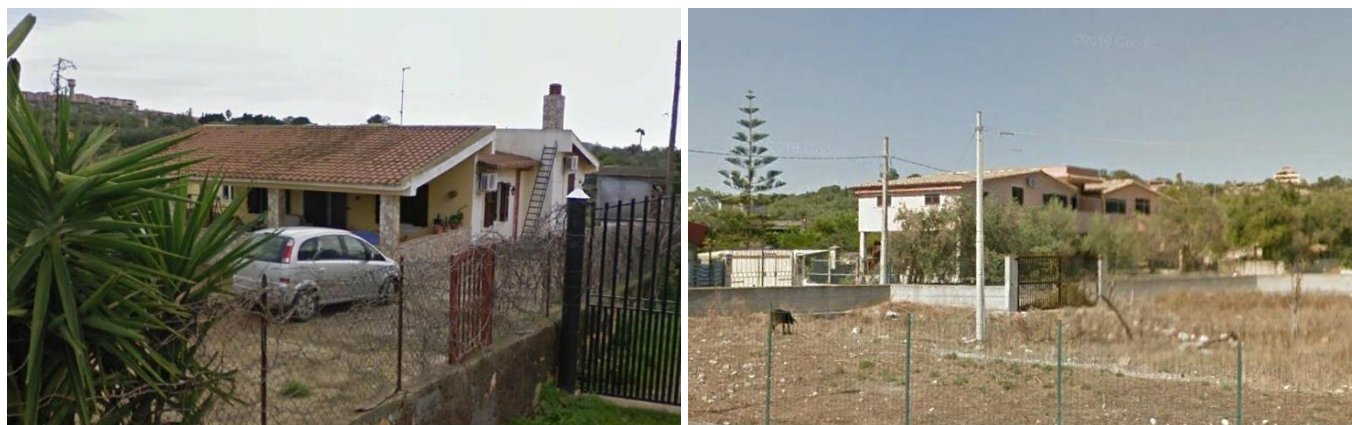
Figura 7-9 Manufatti ad uso residenziale oggetto di demolizione
