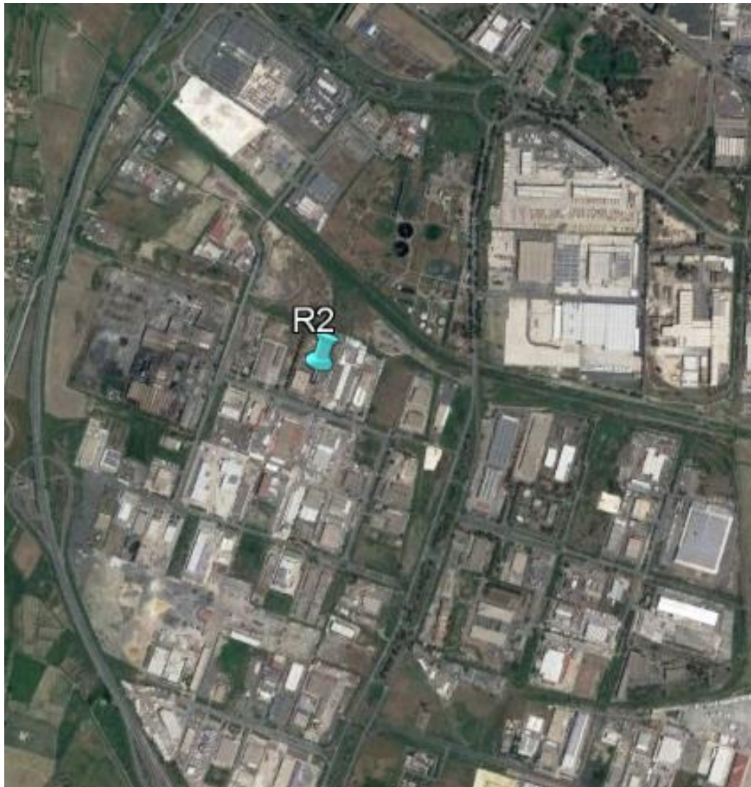
Figura 4-3 - Metal Ferro, foto aerea
