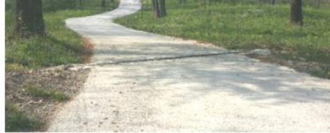
Pavimentazione drenante realizzata con stabilizzanti naturali terreno
