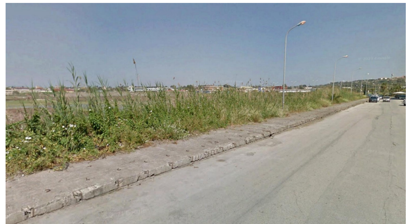
Figura 2-18 Punto di vista 2 Condizioni di visibilità in ambito delle saline
