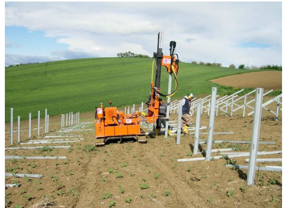
Figura 4 - Posa strutture metalliche di fondazione
