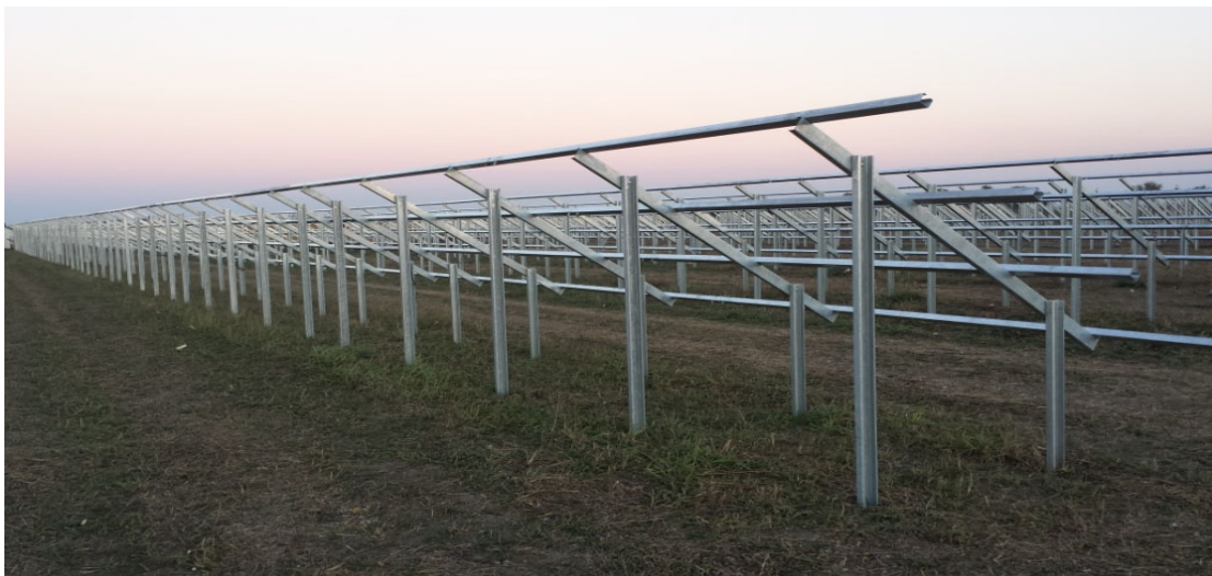
Figura 5 - Stato cantiere al termine della fase lavorativa
