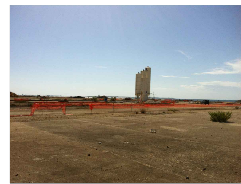
VISTA 30 - Piazzale ex Yard Belleli
