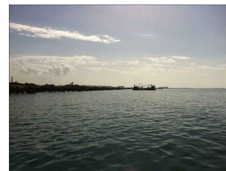
VISTA 16 - Area cassa di Colmata lato ex Yard Belleli
