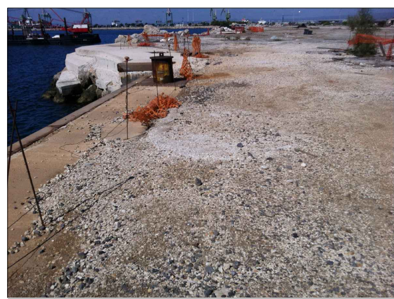
VISTA 26 - Molo ex Yard Belleli particolare Bitta
