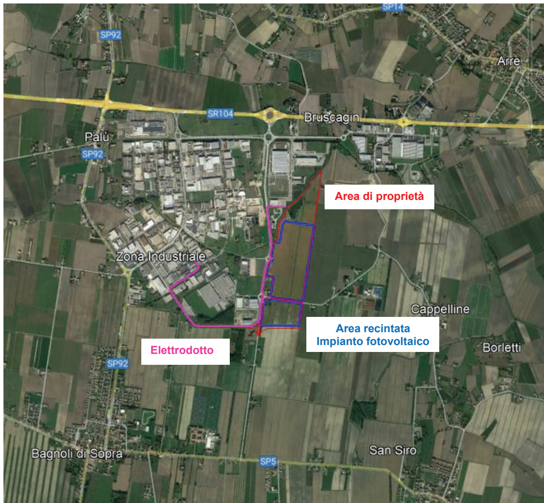
Figura 1-2 – Foto aerea dell'area di intervento (Fonte: Google Earth)
