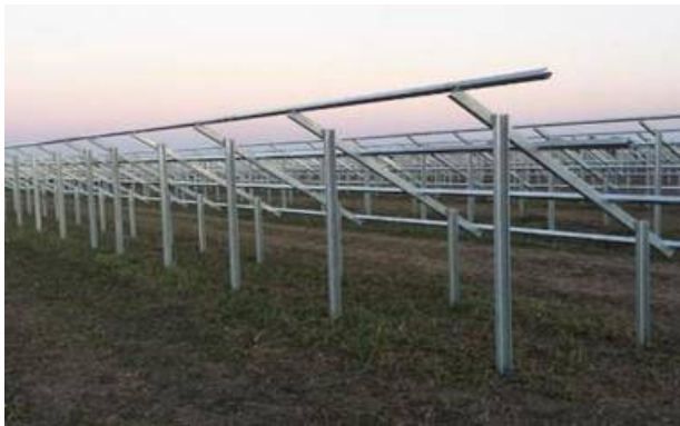
Figura 6-1 – Esempio di posa delle strutture portanti.
