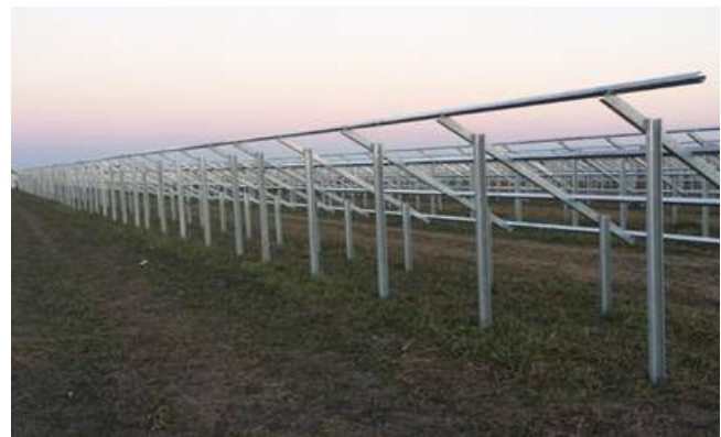
Figura 3-10 - Stato cantiere al termine della fase lavorativa
