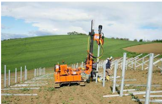
Figura 3-9 – Messa in opera delle strutture di sostegno
