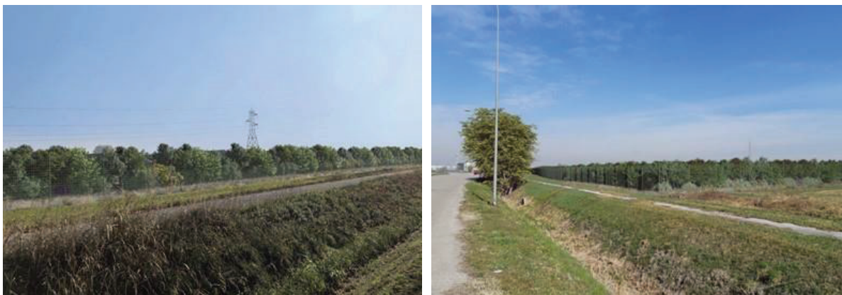
Figura 4-14 – Siepe perimetrale lungo la recinzione
