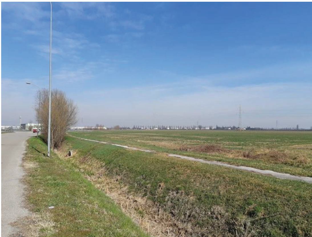
Fotoinserimento 3 - Vista degli impianti BAGNOLI 2, 3 e 4 da viale Europa – ante operam
