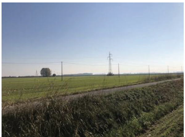
Figura 1-5 – Panoramica area di intervento
