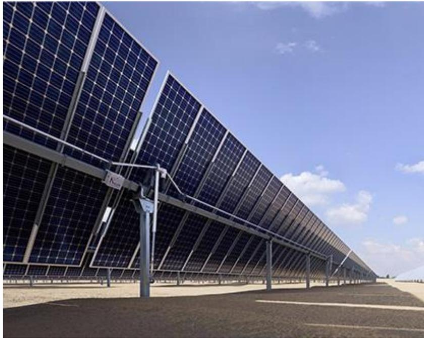
Figura 1 - immagine esemplificativa di struttura tracker in configurazione 2-P
