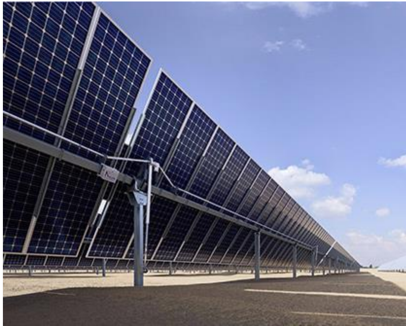
Figura 1 - immagine esemplificativa di struttura tracker in configurazione 2-P
