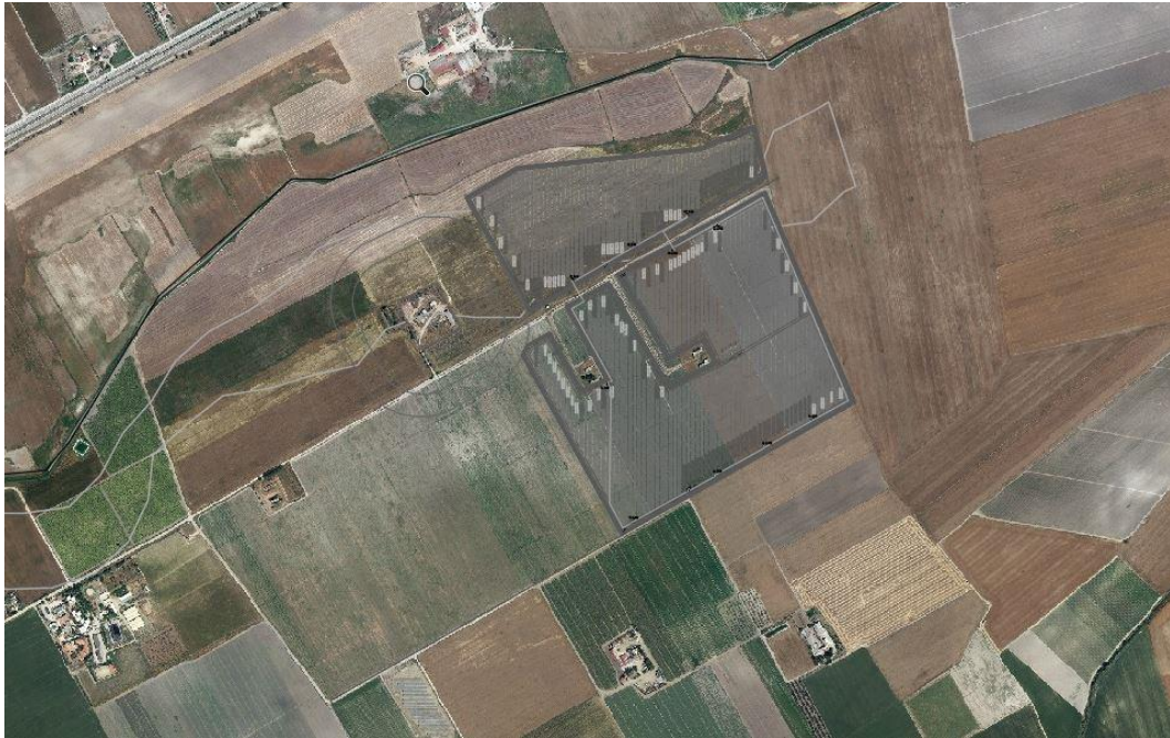
Figura 1-FOGGIA-stralcio fotogrammetrico con il campo fotovoltaico
