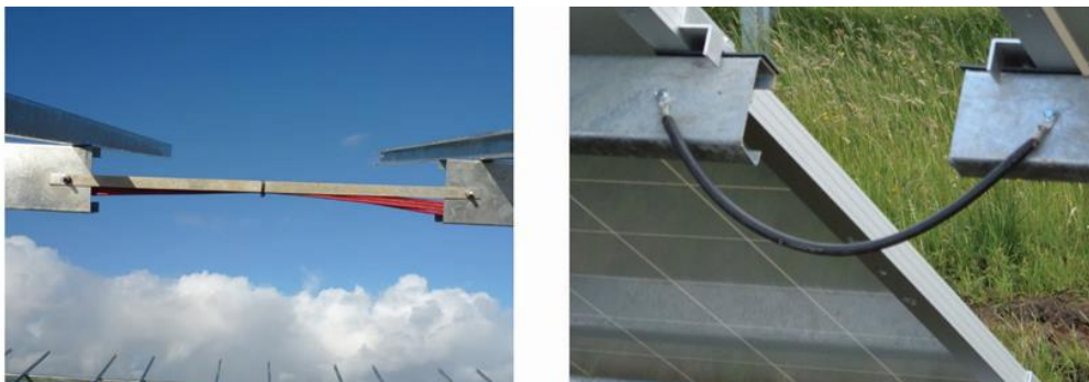
Figura 6: collegamento equipotenziale tra strutture adiacenti
