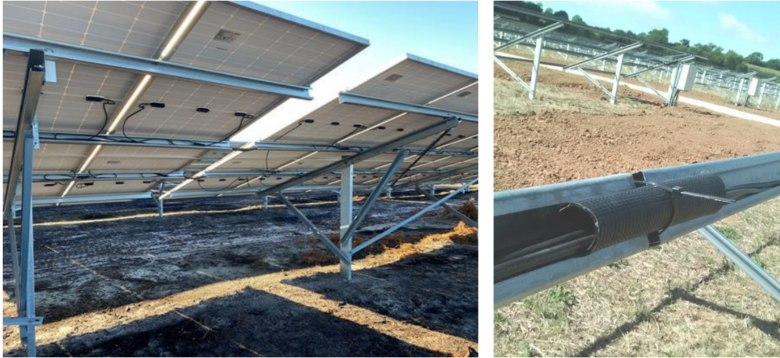
Figura 3: cablaggio stringhe
