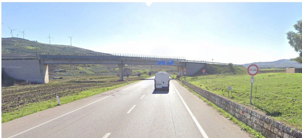
Figura 7: punto di scatto 2, intersezione tra la SS189 e la rete ferroviaria con la SP78
