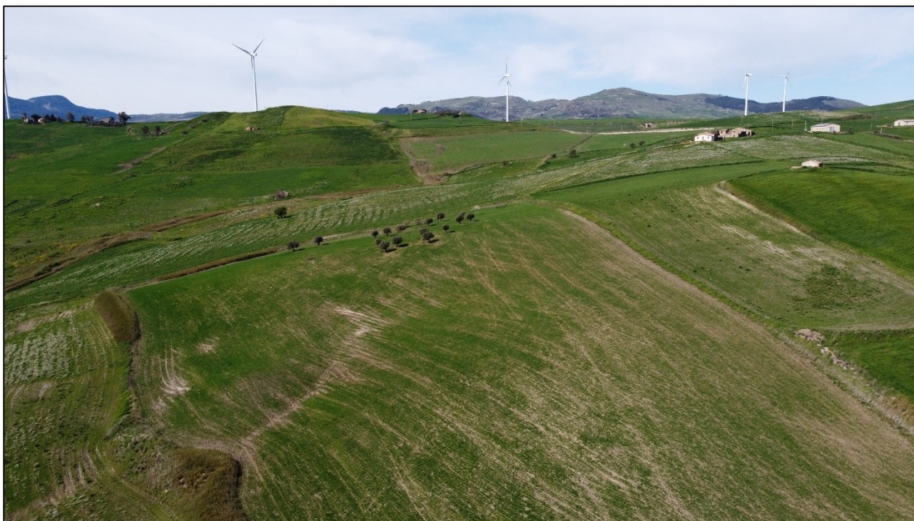
Vista meridionale dell'impianto UR 2
