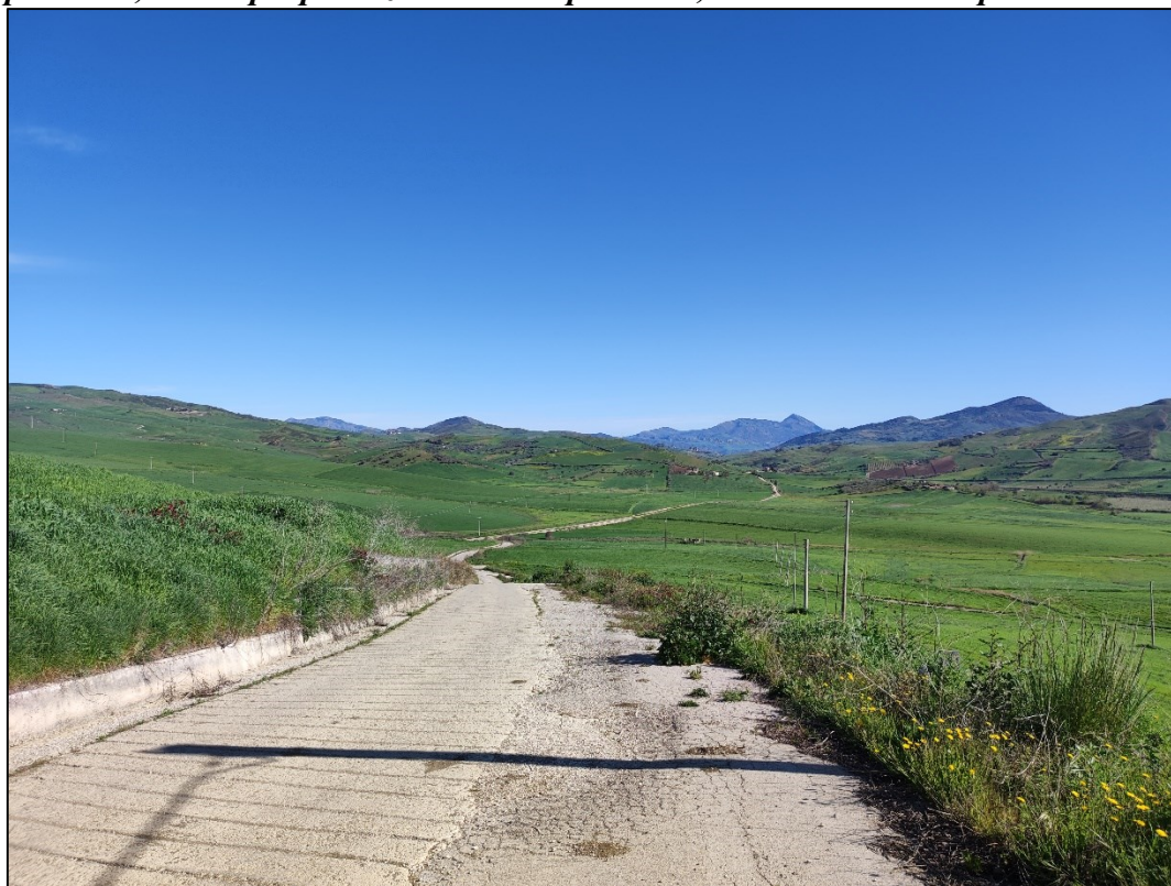
Strada senza denominazione. Percorso cavidotto
