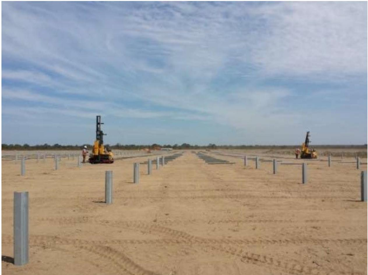
*Figura 17 - Esempio di disposizione dei pali di fondazione delle strutture*
