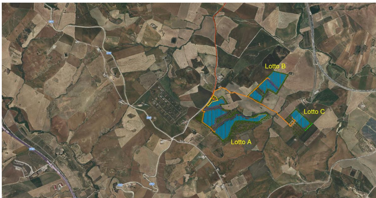
Figura 1 - Inquadramento su ortofoto e CTR area di progetto e opere annesse (Rif. FV.CST01.PD.B.02)
