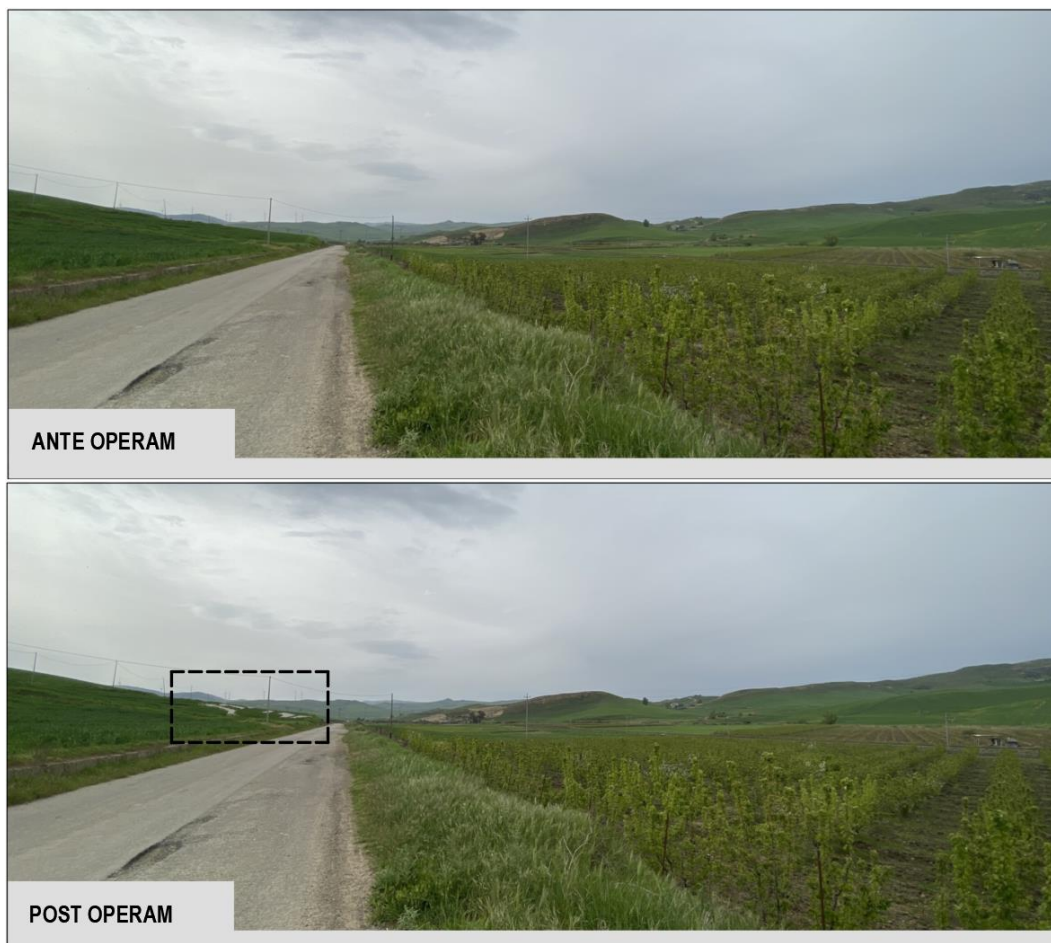
Figura 35 – Scatto F3 effettuato dalla strada comunale che congiunge la SP78 con la SP41, nei pressi della ferrovia, guardando verso l'area di progetto da est
