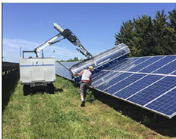
Figura 19 - Pulizia meccanizzata dei pannelli
