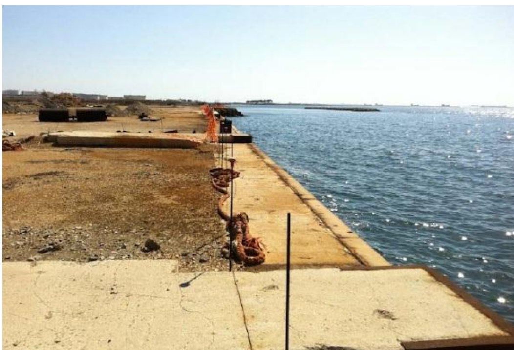
Figura 3.37 – Foto 9, Panoramica banchina in cemento armato, direzione fotografica SE
