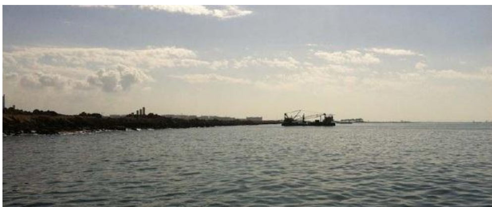
Figura 3.20 – Foto 10, Panoramica porzione centrale area Cassa Colmata yard Belleli, dir. fotografica SE
