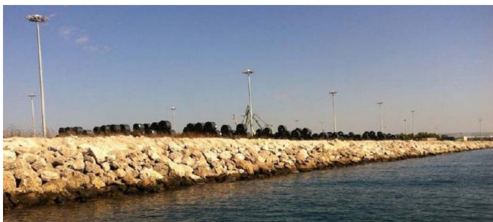
Figura 3.19 – Foto 8, Particolare argine esterno scogliera frangiflutto testata 5° sporgente, dir. fotografica SE
