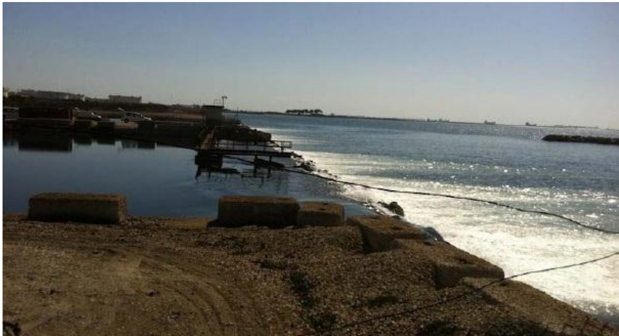
Figura 3.39 – Foto15, Panoramica area scarichi ILVA confine Sud area Belleli, direzione fotografica SE
