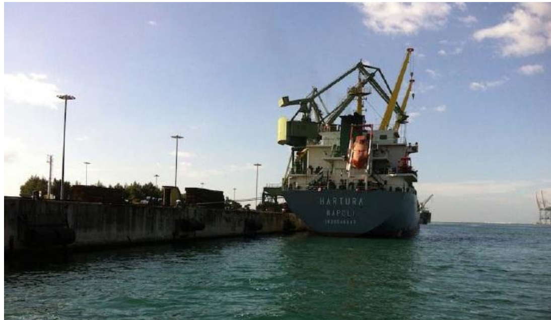
Figura 3.17 – Foto 5, Panoramica banchina 5° sporgente, direzione fotografica SO
