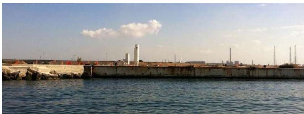
Figura 3.23 – Foto 13, Particolare banchina in muratura Yard Belleli, direzione fotografica NE
