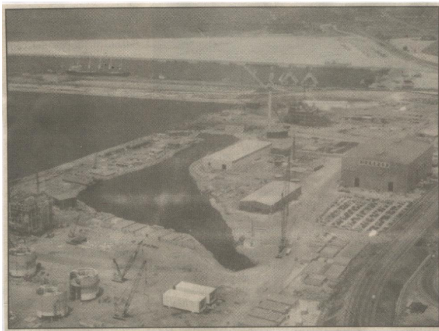
Figura 3.5 – Fotografia storica del nuovo canale di scarico Italsider
