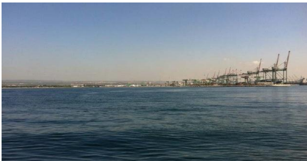
Figura 3.26 – Foto 20, Panoramica area di dragaggio di manovra navi, direzione fotografica NE
