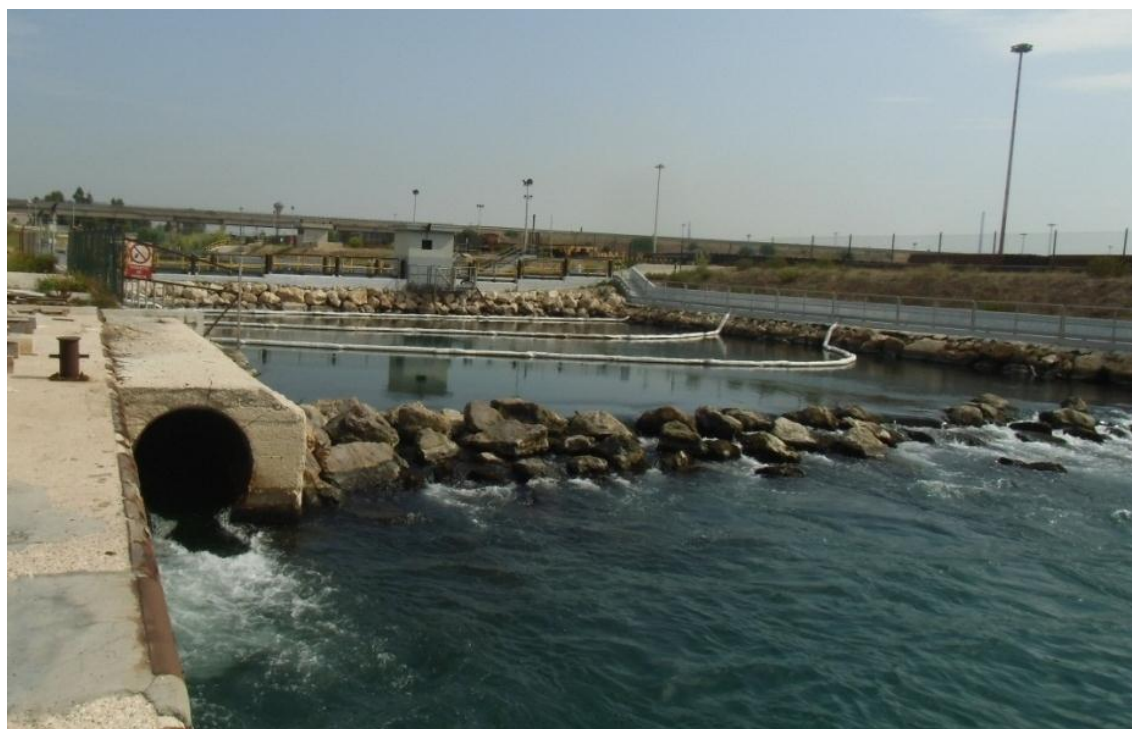
Figura 4.5 – Scarico a mare del canale “fiumetto” a sinistra e del 2° canale ILVA a destra
