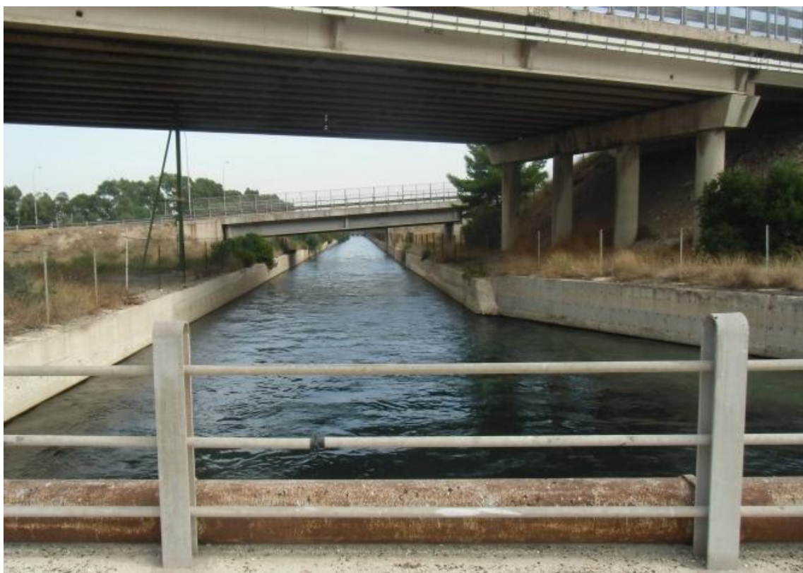
Figura 4.6 – 1° Canale ILVA a monte dell'intersezione con la SS106
