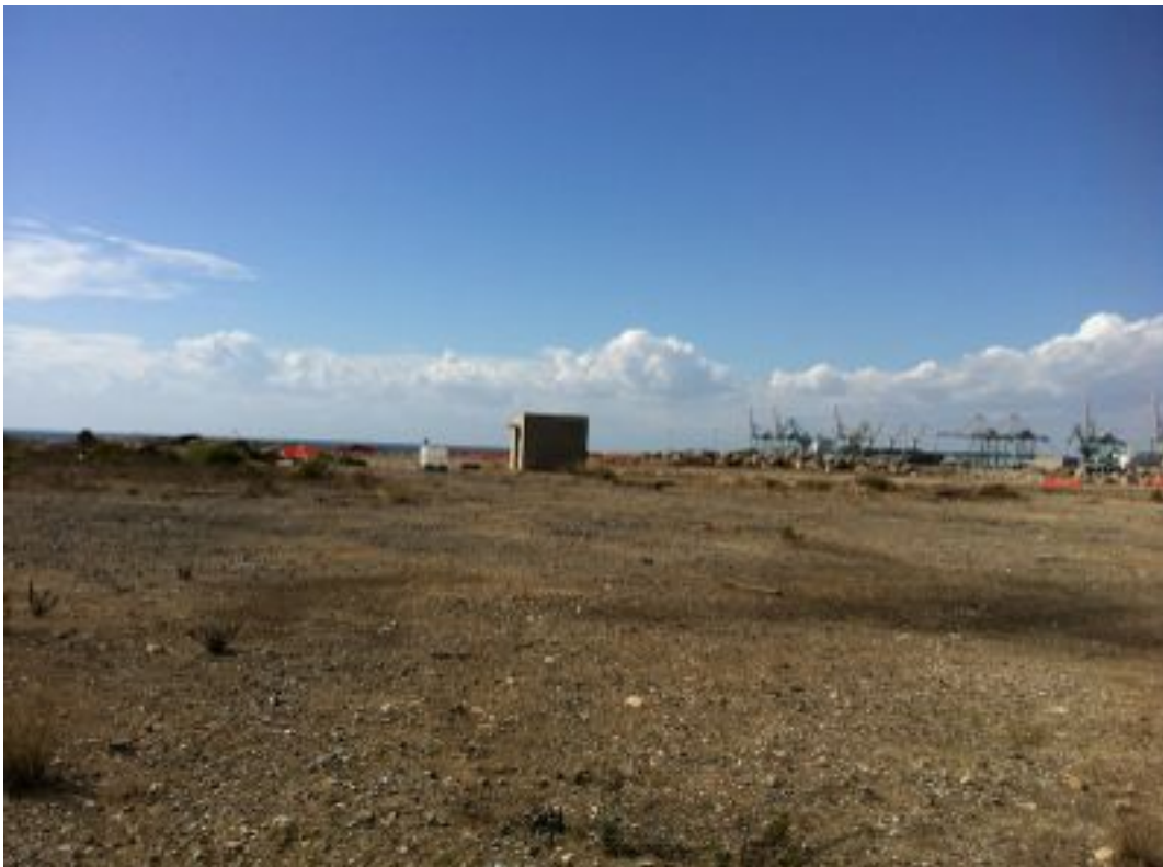
Foto 30. Panoramica piazzale cementato lato nord area Belleli, dir. fot. Nord
