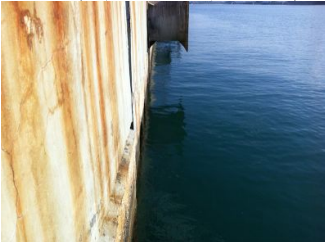
Foto 16. Particolare porzione terminale banchina di attracco navi, dir. fotografica NE
