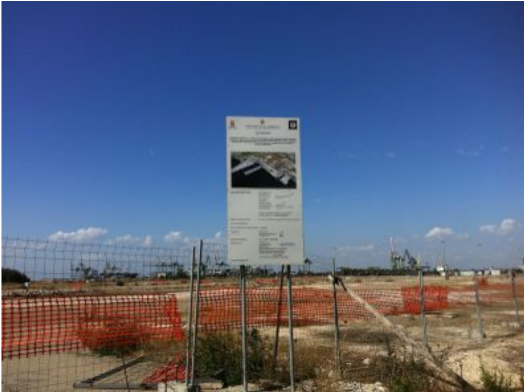
Foto 1. Ingresso area Yard Belleli, direzione fotografica Sud
