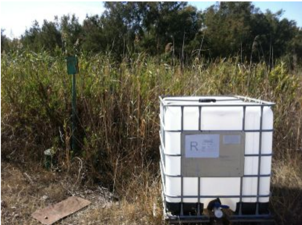
Foto 32. Particolare pozzo di bonifica di falda con serbatoio di accumulo acque prelevate, dir. fot. SO
