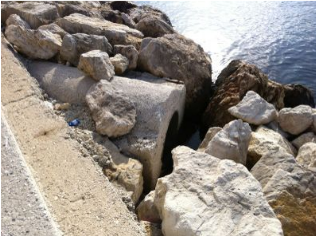
Foto 12. Porzione terminale primo canale di scarico acque prima pioggia del molo, dir. fotografica NE
