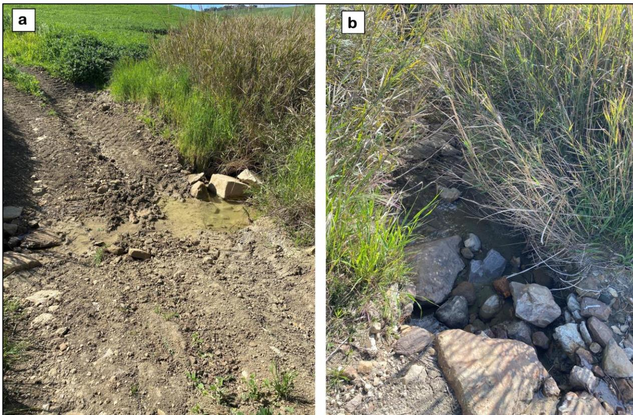
Figura 15 - Foto dell'interferenza I.IDR.02 ottenuta mediante sopralluogo in sito: a) mostra l'attraversamento del rivolo sulla strada sterrata attualmente esistente; b) mostra il fosso in cui l'alveo si rigetta in seguito all'attraversamento
