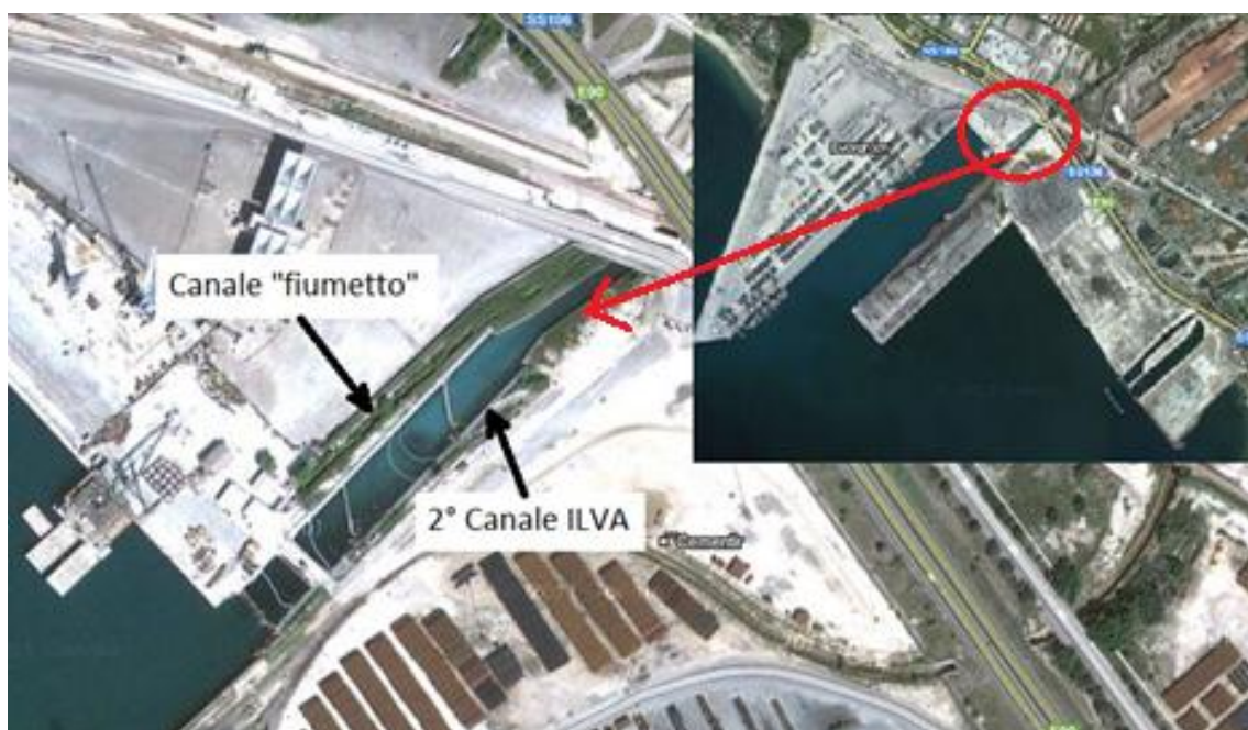
Figura 8.39 – Veduta aerea del canale "fiumetto" e del 2° canale ILVA
