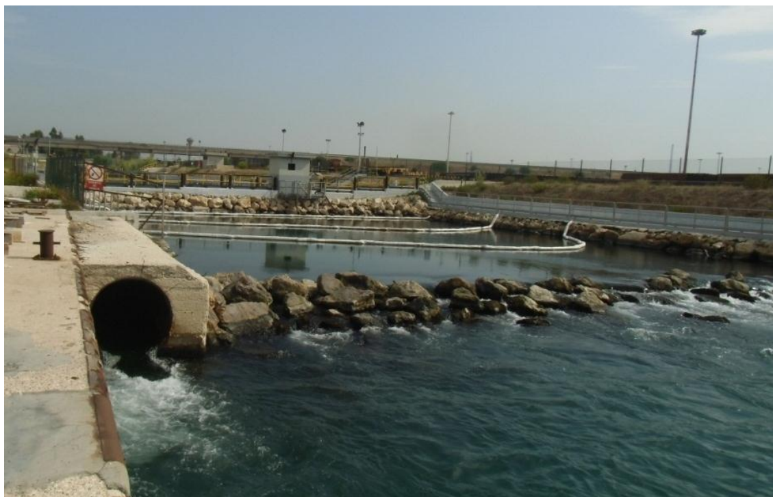
Figura 8.40 – Scarico a mare del canale “fiumetto” a sinistra e del 2° canale ILVA a destra
