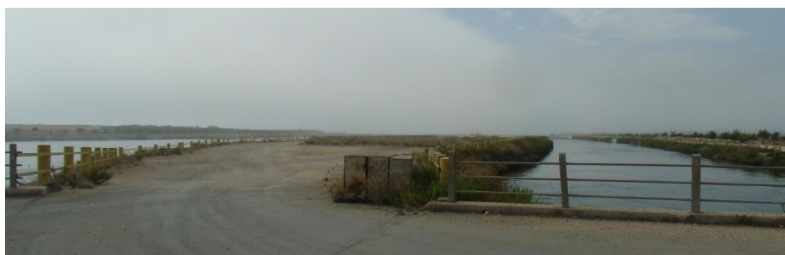
Figura 8.42 – 1° Canale ILVA a valle dell’intersezione con la SS106
