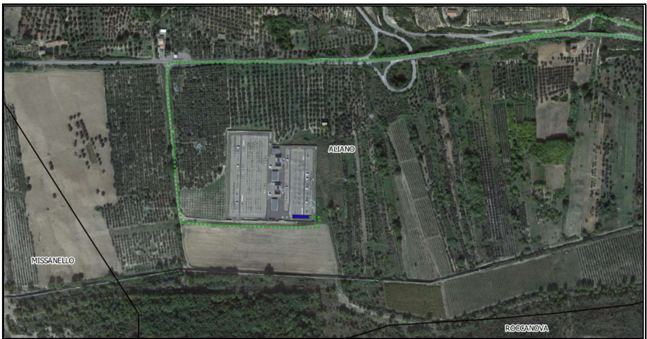
Figura 2.3.6.1: Individuazione su ortofoto dello stallò AT nella stazione Terna
