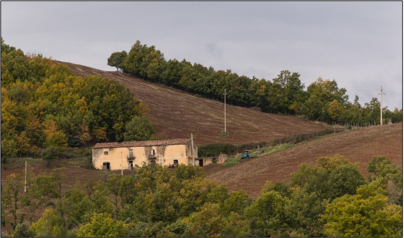
Figura 4.1.5.1. Foto da sopralluogo del fabbricato diruto R36
