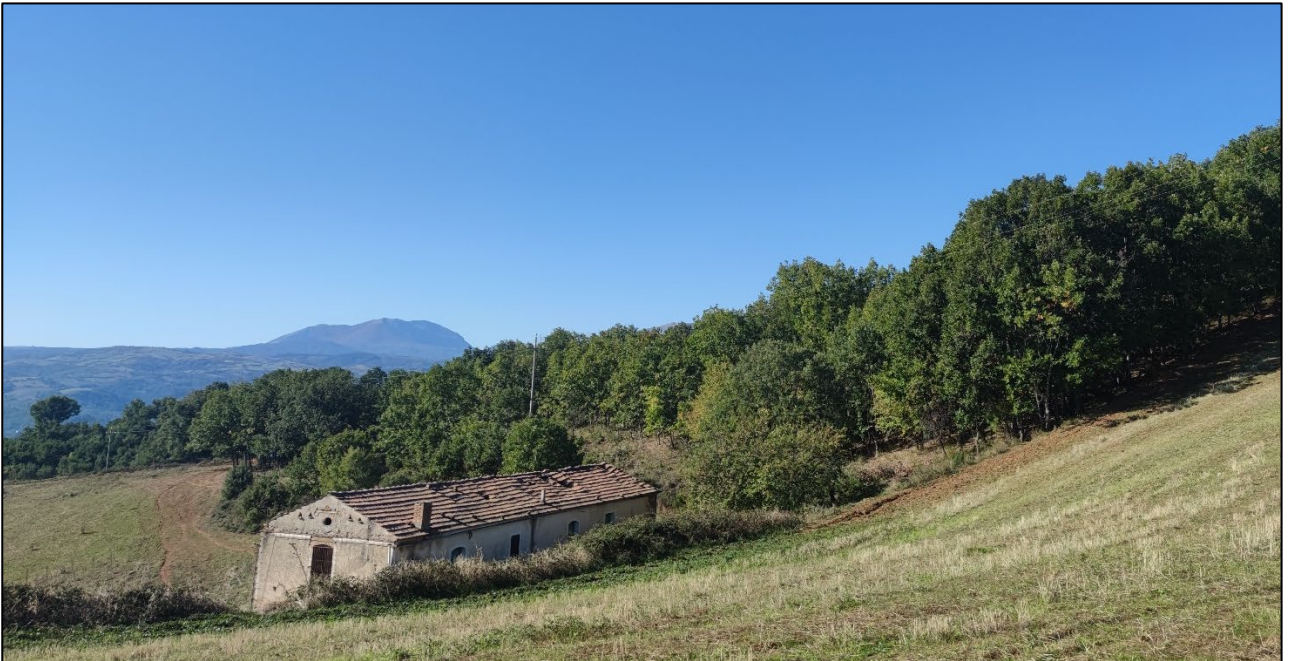
Figura 4.1.5.2. Foto da sopralluogo del fabbricato diruto R36
