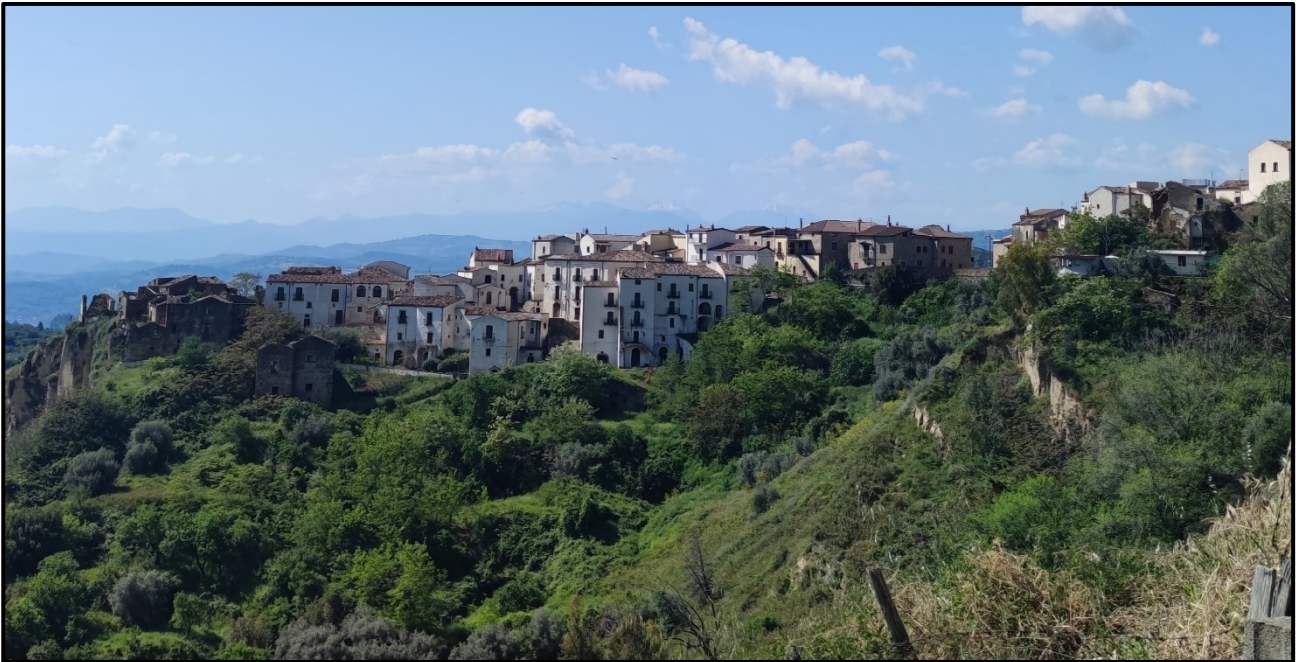
Figura 4.5.10: Vista Panoramica Comune di Aliano
