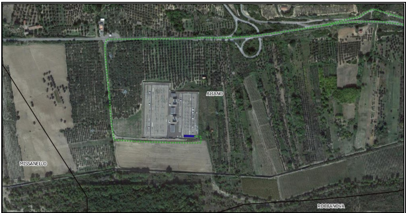
Figura 2.3.6.1: Individuazione su ortofoto dello stallo AT nella stazione Terna
