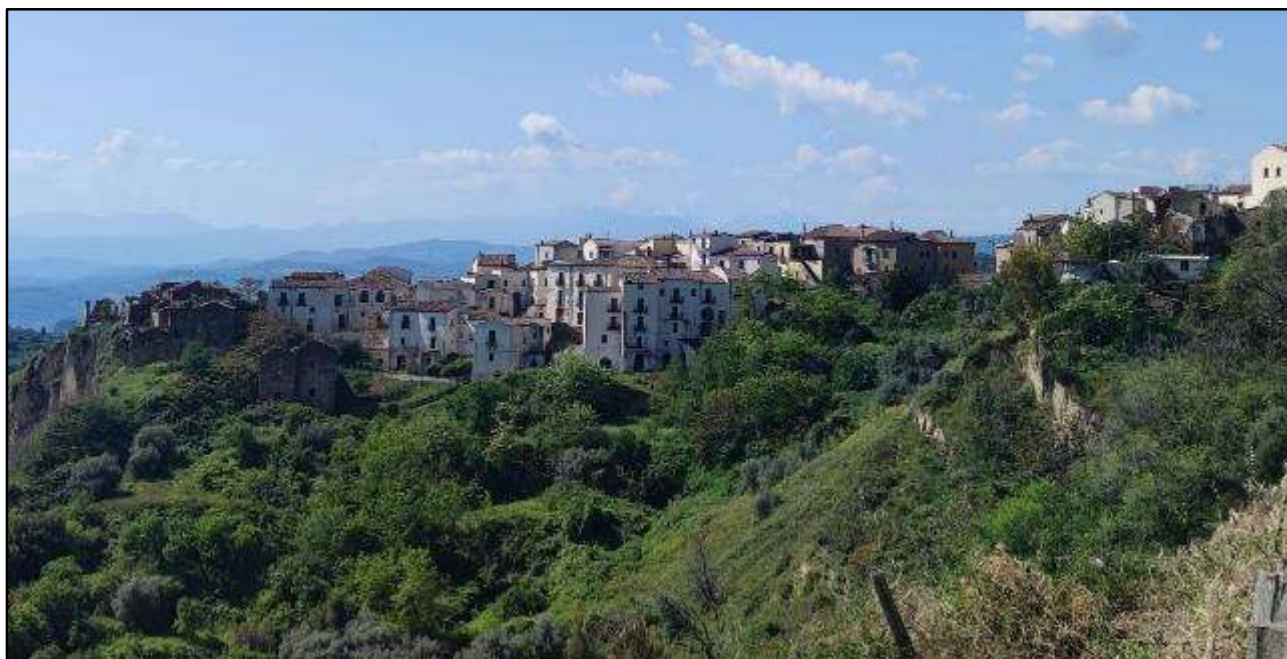
Figura 8.9: Vista Panoramica Comune di Aliano
