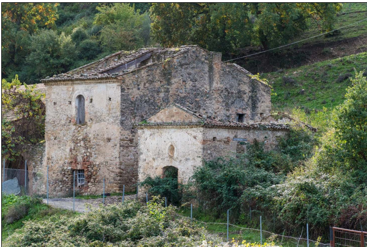
Foto 7.1.4.12: Palazzo Castiglione nel Comune di Missanello
