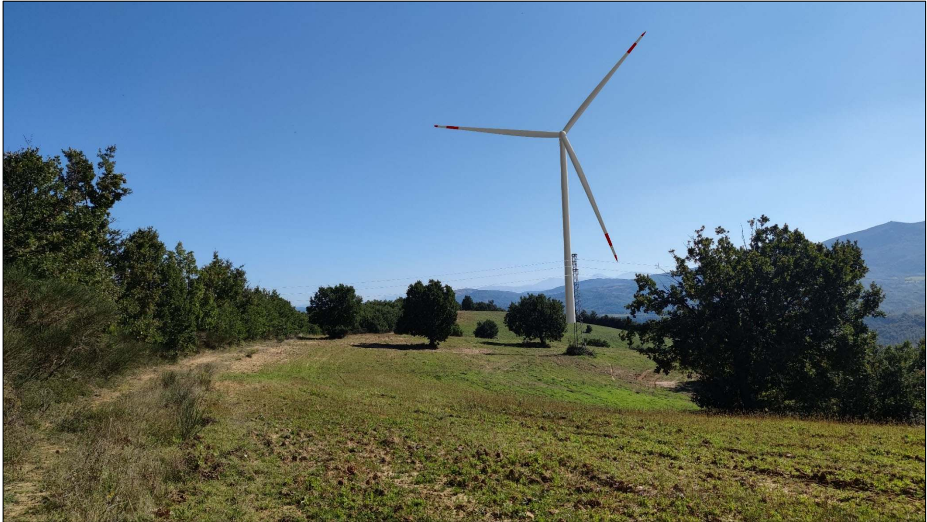
Foto 8b: Punto di ripresa fotografica P08 ( 40.287662^{\circ} , 16.013776^{\circ} ) – Direzione Foto 150^{\circ} – Vista area WTG AR01 Post Operam
