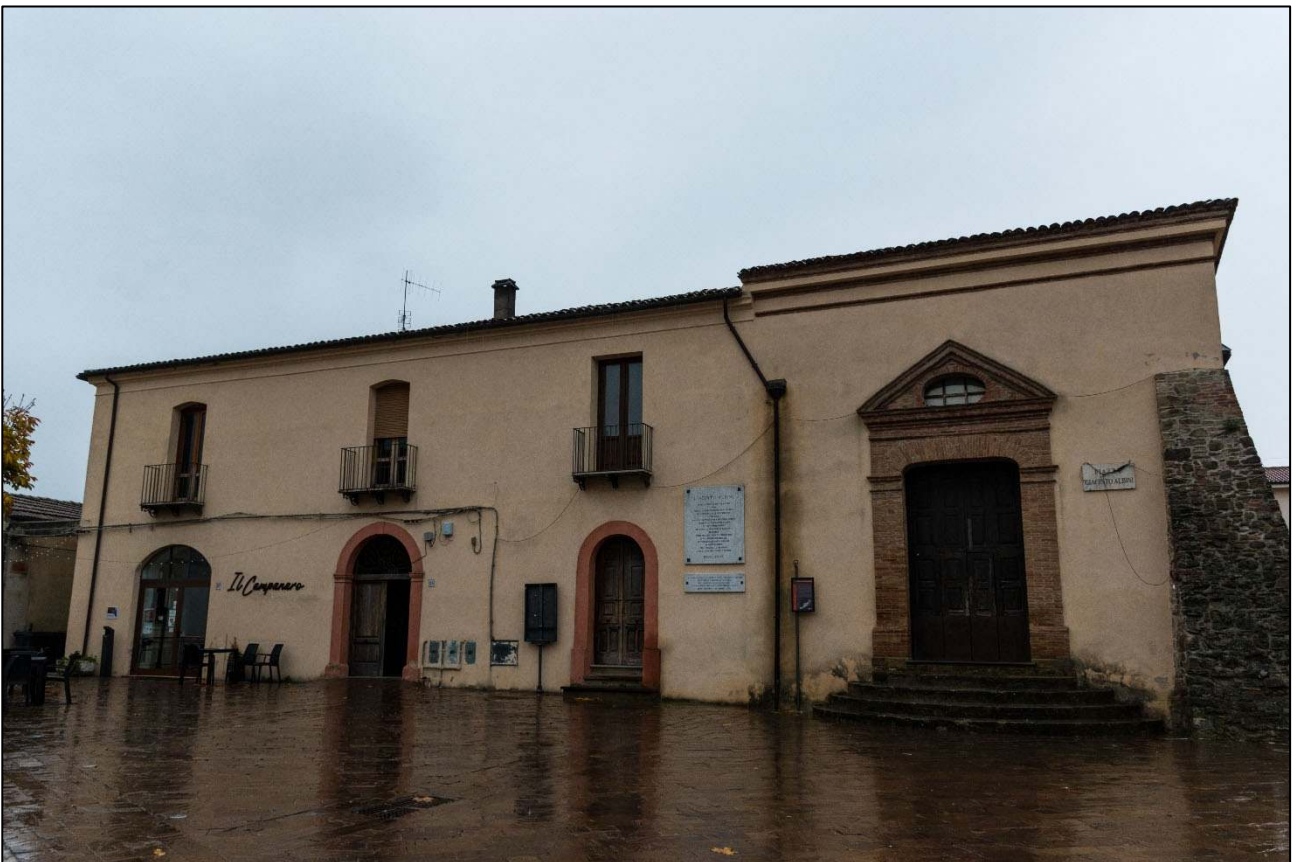
Figura 7.1.4.8. Ex Convento dei Domenicani nel Comune di Montemurro
