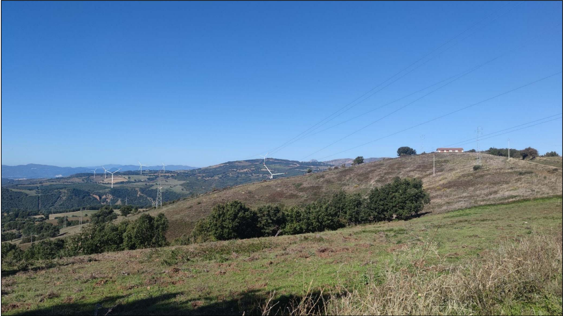
Foto 3b: Punto di ripresa fotografica P03 (40.287609°, 16.102619°) – Direzione Foto 292° – Vista area WTG AR01, AR02, AR03, AR04, AR05, AR06 e AR07 Post Operam
