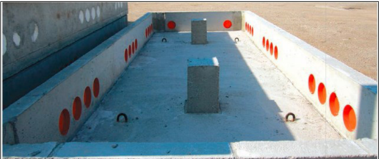
Figura 18 Vasca di fondazione in CAV
