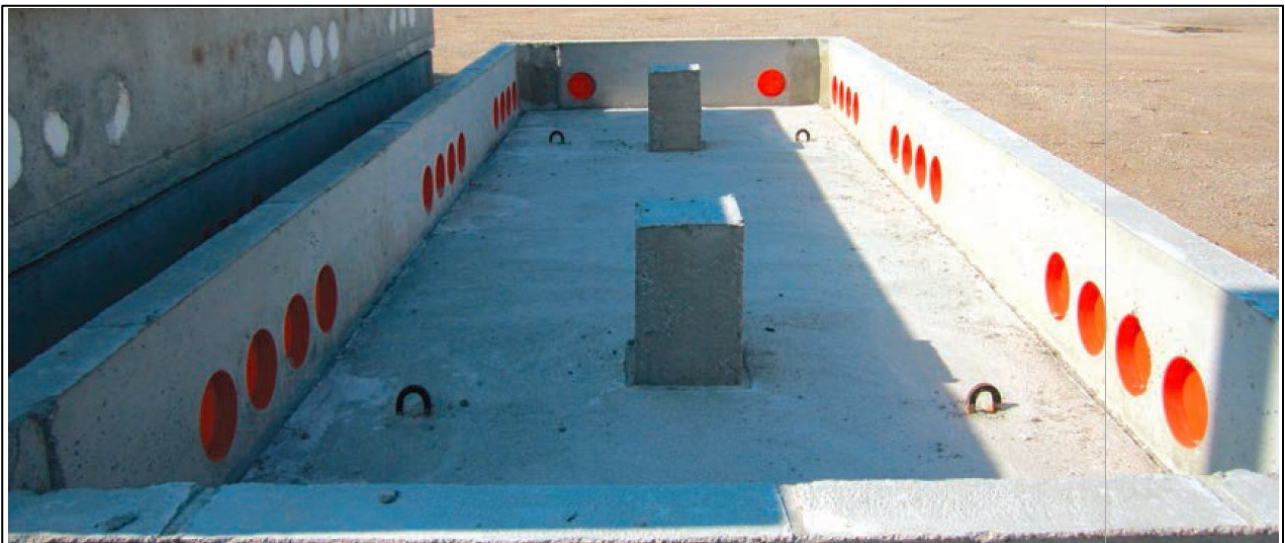
Figura 4 Vasca di fondazione in CAV
