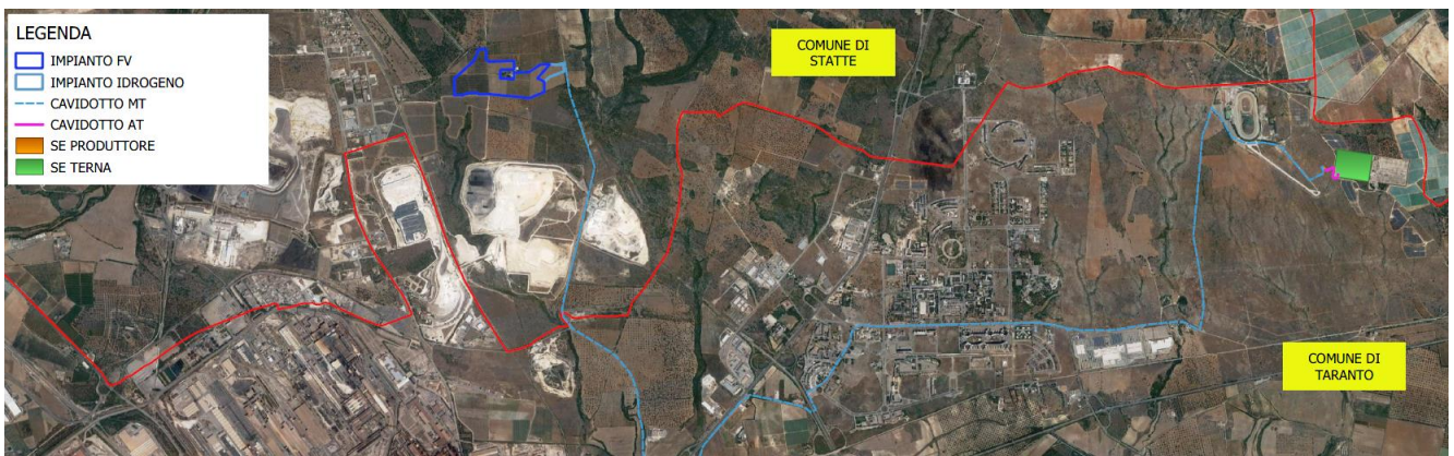
Figura 4-4: Inquadramento territoriale su Ortofoto del complesso del percorso del cavidotto di connessione MT (in azzurro)
