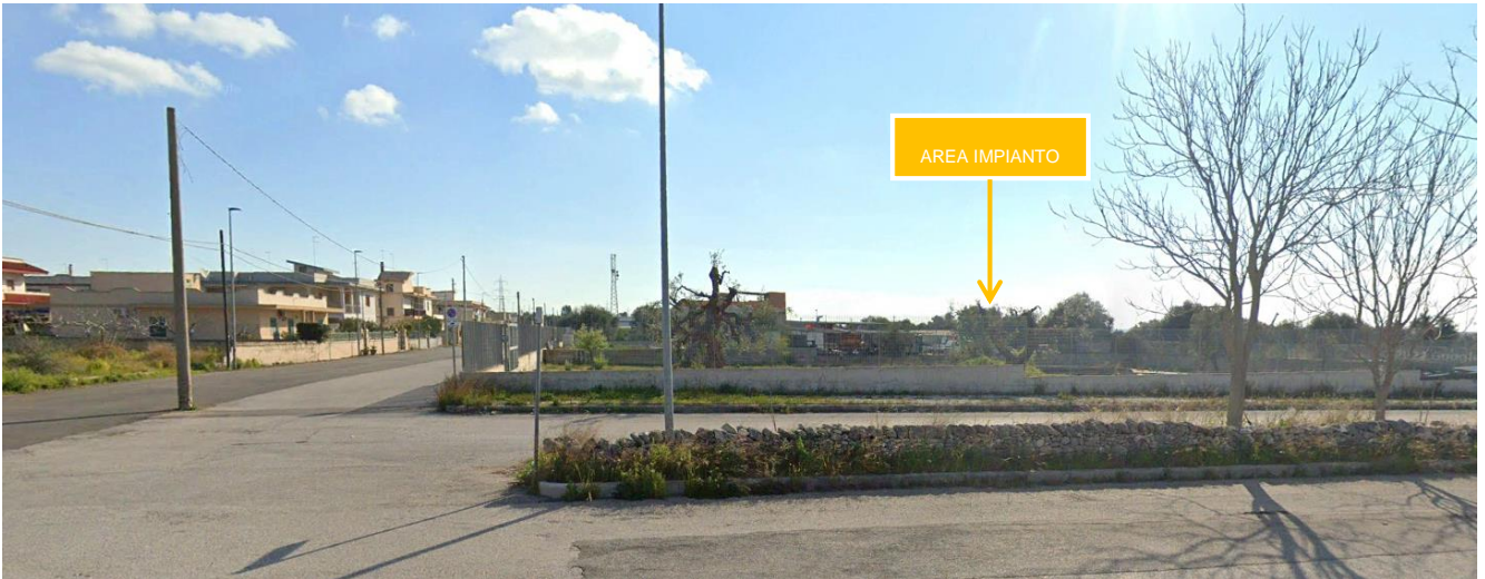
Figura 2-25: Vista dal Punto A Masseria Felicciolla verso l'area di impianto
