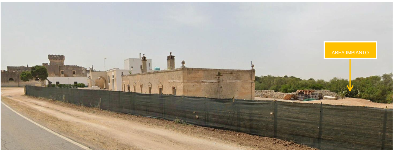
Figura 2-26: Vista dal Punto B Masseria Todisco verso l'area di impianto
