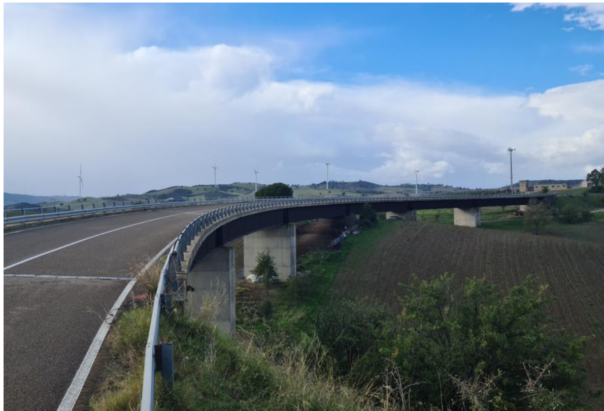
Figura 22: Opera di attraversamento idraulico
