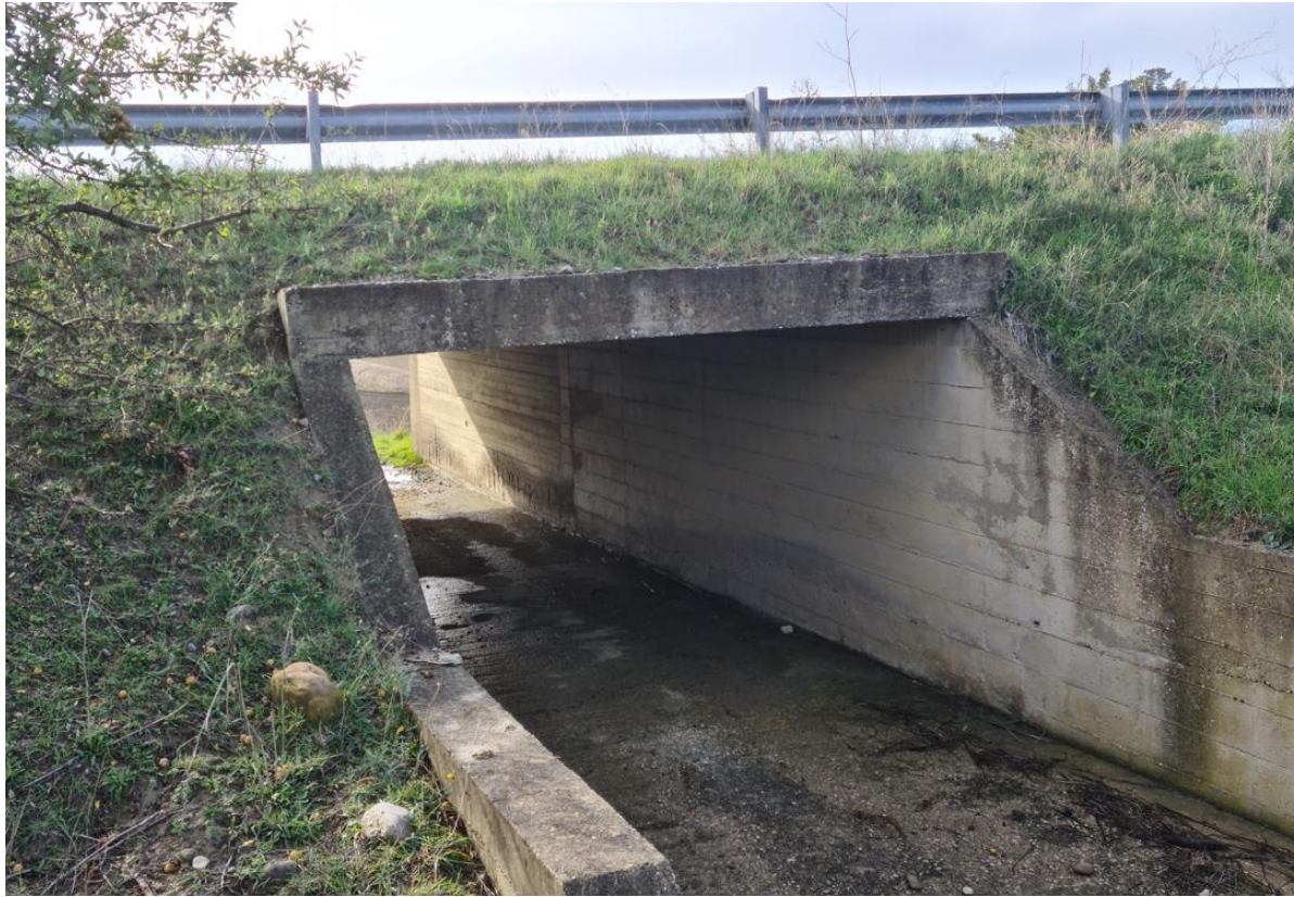
Figura 21: Opera di attraversamento idraulico
